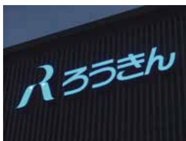
壁面文字(LED内照式) 写真：静岡県労働金庫 浜松中央支店
