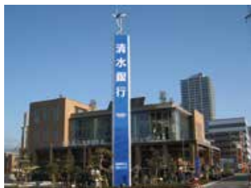
看板上部に風力発電装置を設置
