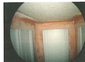
袖看板内部鉄骨
