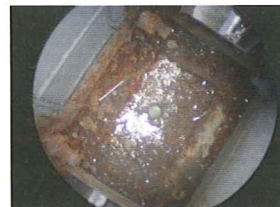
ブラケット内部鉄骨
