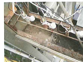
袖看板内部鉄骨
