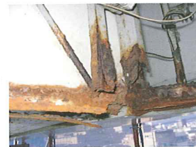
屋上広告塔下端鉄骨
